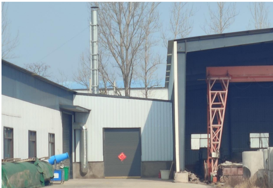
15m 高排气筒
